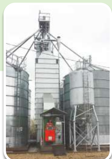
Arzatorul ecoHORNET AHP700 a inlocuit injectorul pe motorina la un generator de aer cald ce deserveste un uscator de cereale. (Targul Jiu, Gorj)
